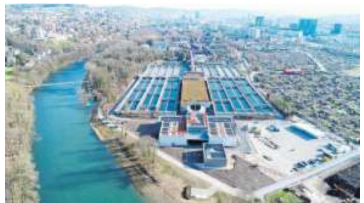
Die ARA von Entsorgung + Recycling Zürich als Energiequelle für den Energieverbund.
