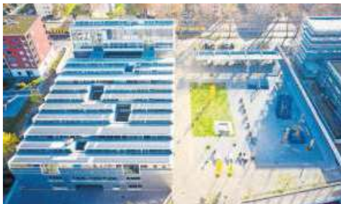
Photovoltaikanlage mit rund 500 Panels auf dem Dach des Schulhauses Reitmen Bilder: zvg
